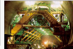
Construcción de Restauración
